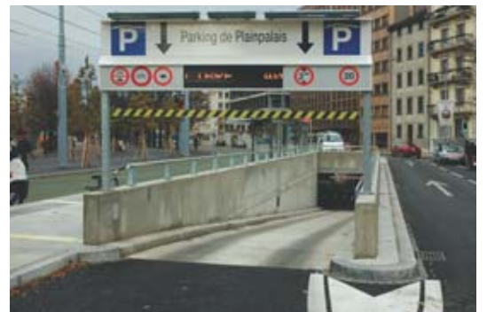
Entrée parking de Plainpalais
