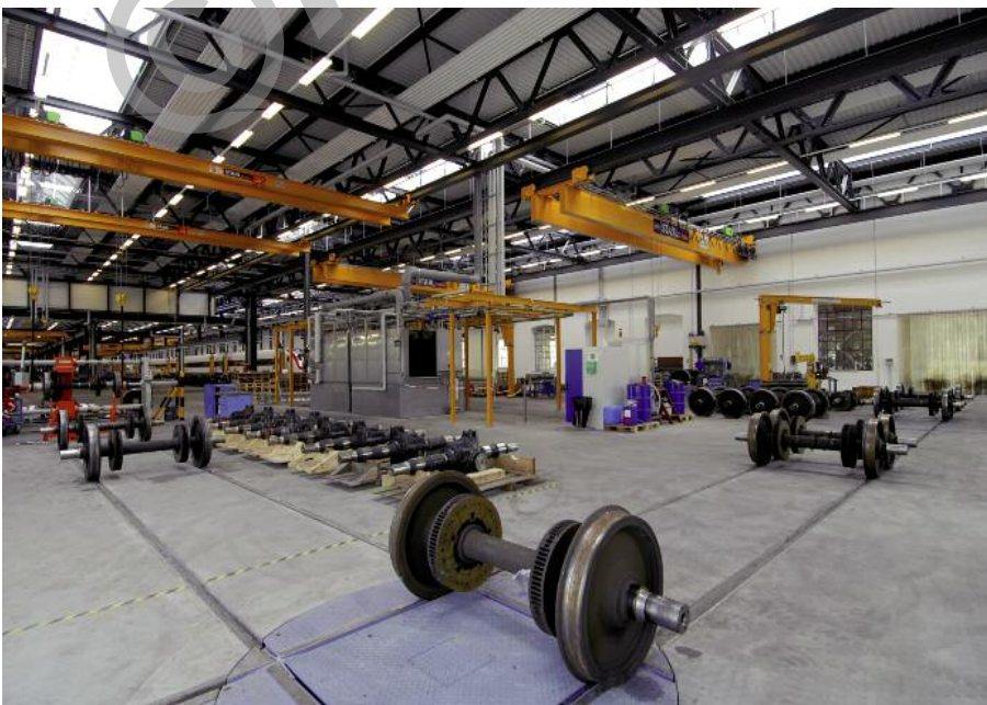
Structure métallique et toiture en shed
