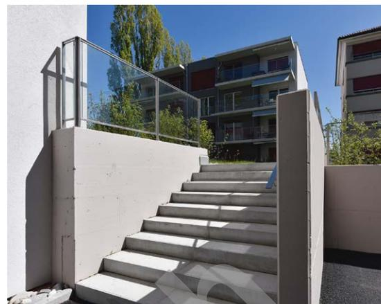
une structure en béton armé, une isolation périphérique de 20 cm et des balcons préfabriqués. Les menuiseries sont en PVC avec triple vitrage isolant, les garde-corps en verre enserrés dans des profils métalliques polis. Cette tendance simple et éprouvée se poursuit à l'intérieur avec du papier peint et du parquet dans les chambres et les salons, du carrelage et de la faïence dans les salles d'eau.
