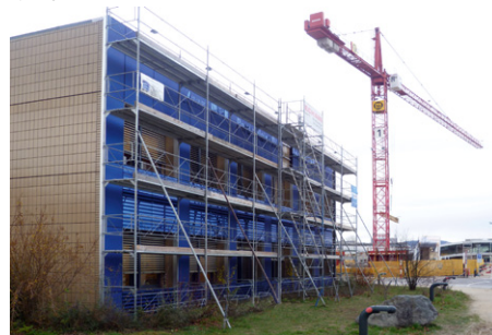
5) Façade Swissinso en voie de finition
