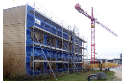
5) Façade Swissinso en voie de finition
