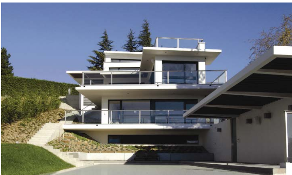
Vue sud avec piscine
