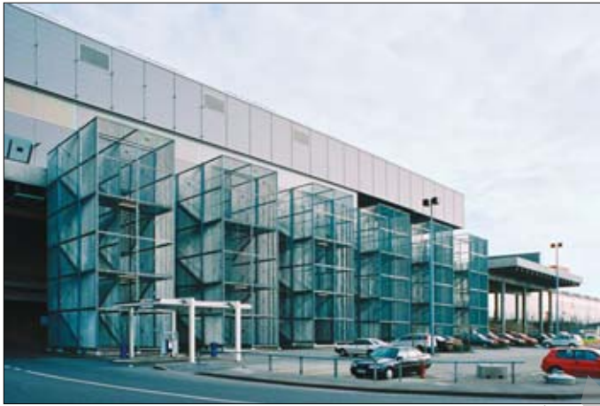
Escaliers de secours côté Aéroport
