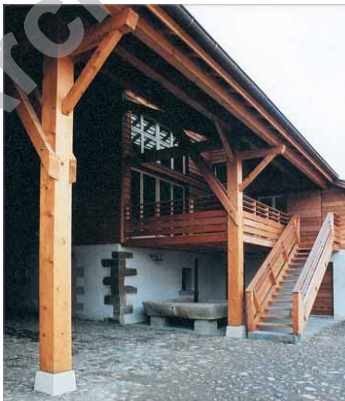
Détail de la structure bois
