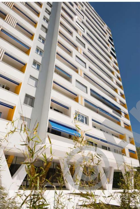
balcons, qui ont été remplacés par des panneaux composites. Constitué de deux tôles d'aluminium avec un noyau minéral, ce matériau présente l'avantage de la polyvalence de ses surfaces et de ses couleurs.
