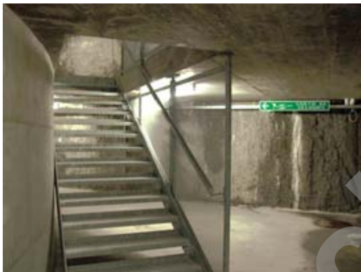
Couloir de fuite
