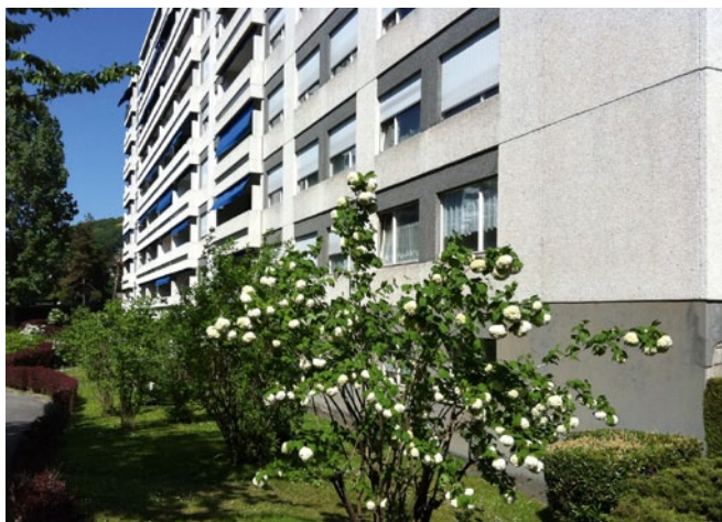
Façade avant travaux
