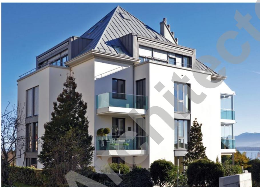
Construits sur une base structurelle classique en béton armé et maçonnerie, les constructions sont surmontées d'une charpente en bois couverte par une toiture en tôle de zinc titane.
