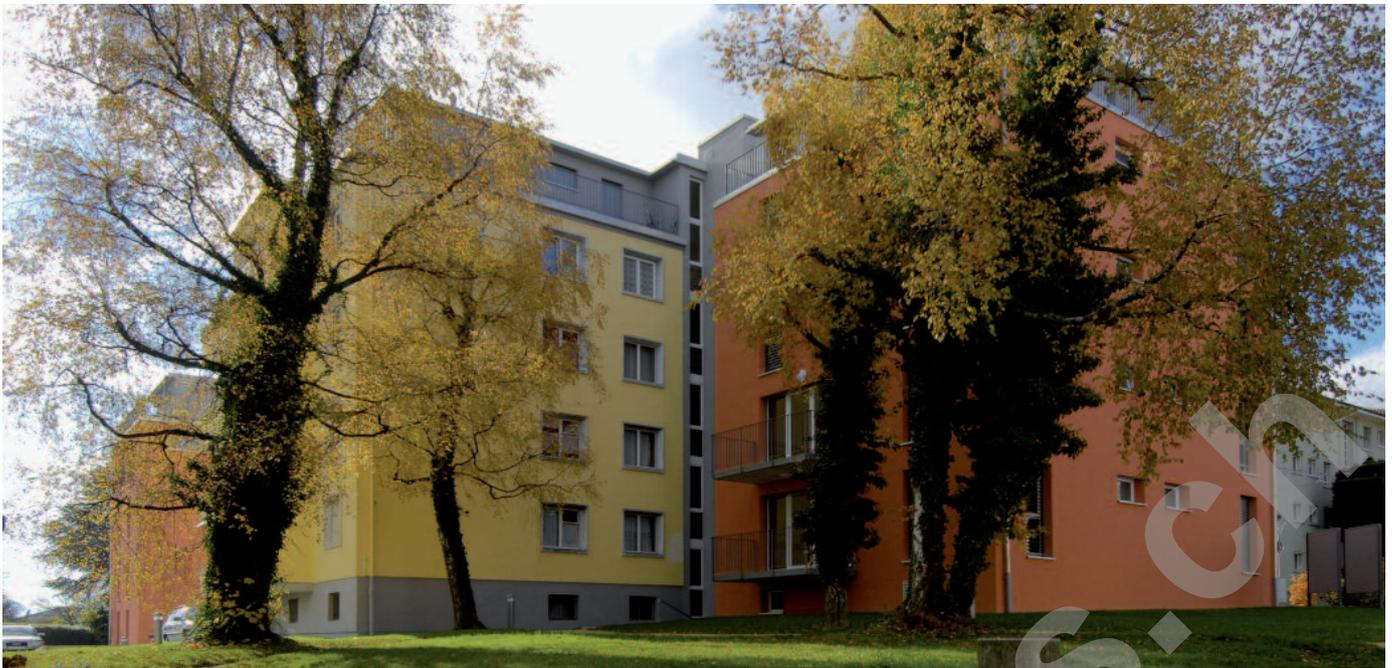
Les toitures, plates, après démolition de la toiture existante, sont isolées/étanchées par système multicouches, et les façades, crépies sur isolation périphérique.
