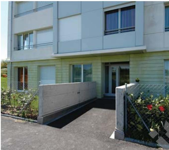
Sur le plan constructif, les immeubles dont la structure est réalisée en béton armé, sont fondés sur un radier général. Les façades, porteuses, sont constituées d'éléments préfabriqués lourds, dotés d'une isolation interstitielle. Leur toiture plate est isolée/étanchée par un système multicouche traditionnel.
