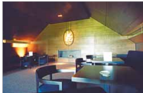
Parois en sous pente habillées de wengé
