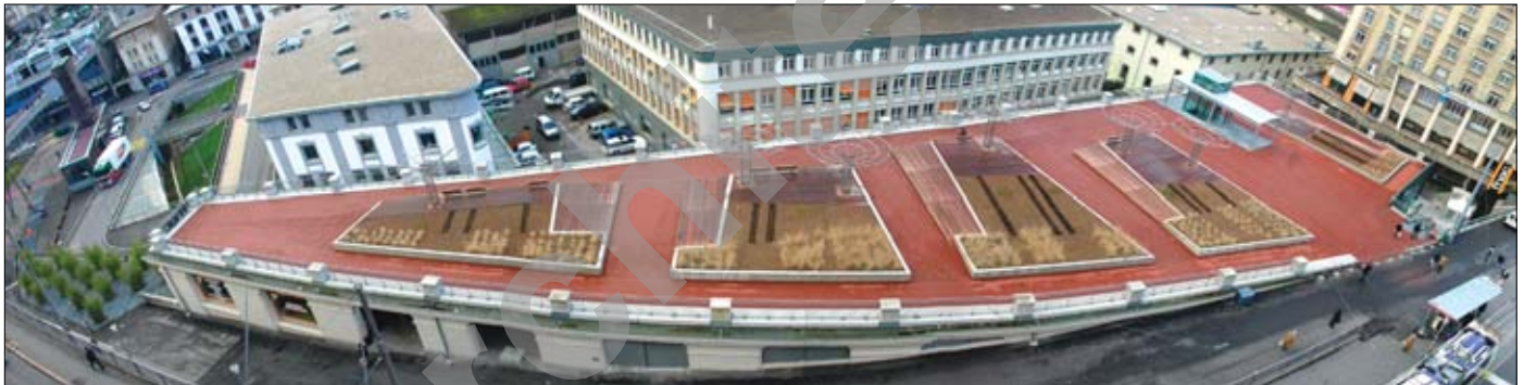
Photo panoramique toiture: Hüster sàrl
