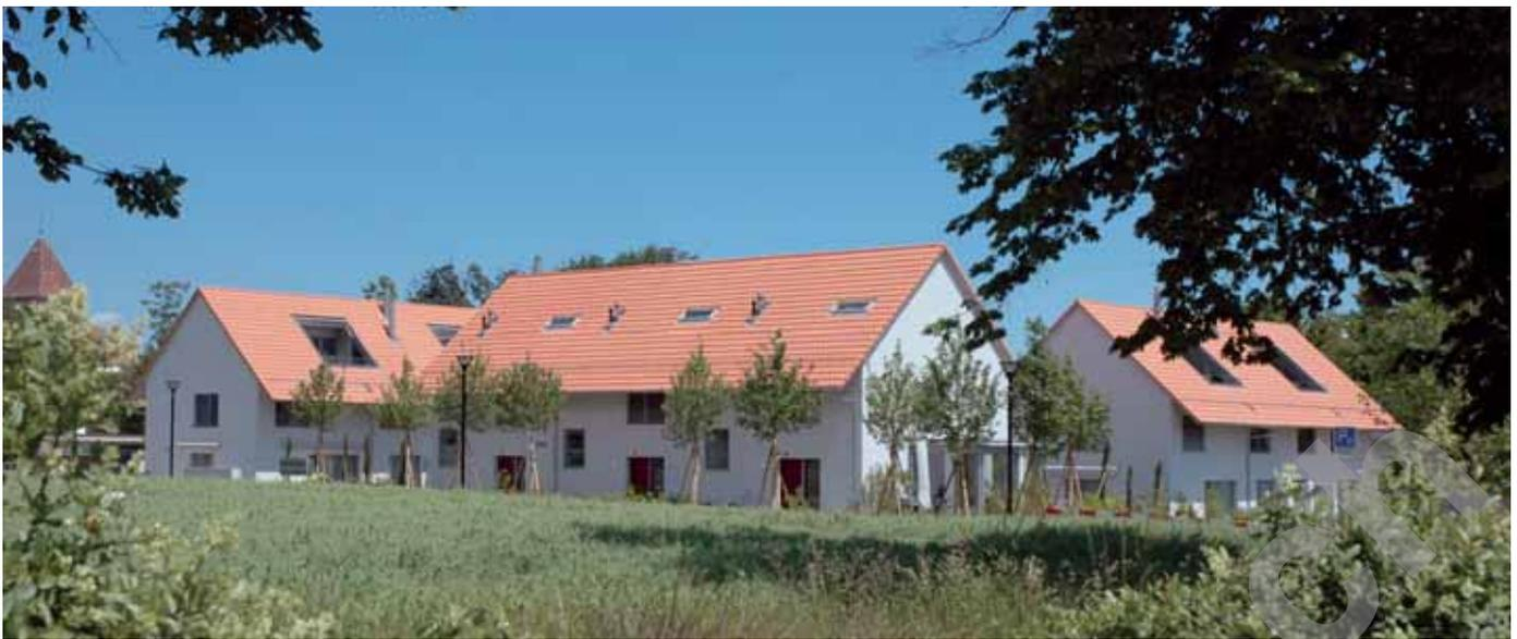
les doubles murs mitoyens étant réalisés en briques de terre cuite avec isolation phonique interstitielle. L'isolation thermique consiste en une enveloppe de polystyrène épaisse de 120 mm, appliquée extérieurement comme support au crépi de finition. Les vitrages, équipés de stores à lamelle et de verres isolants 1,1 W/m<sup>2</sup>K sont réalisés en bois/aluminium, et dotés ponctuellement d'ouvertures oscillo-battantes.
