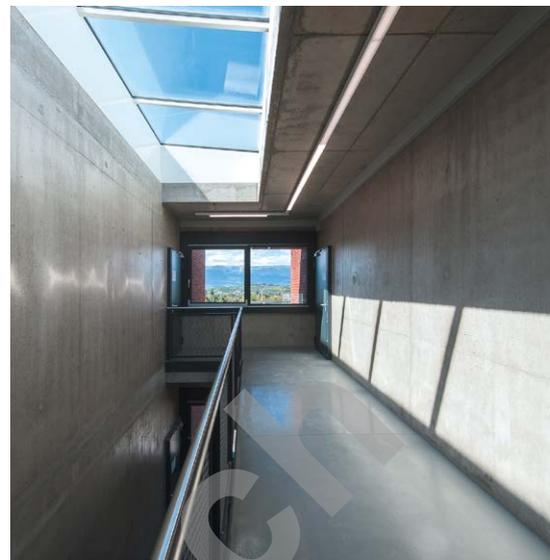
adéquat aux lots, est munie d'un escalier central métallique RAL 7016 de couleur gris anthracite avec des marches en caillebotis rectangulaire, le tout rehaussé d'un garde-corps en métal déployé. Des ouvertures en toiture apportent des puits de lumières et une luminosité optimale sur la cage centrale, dans laquelle se trouve le monte-charge desservant les différents lots du bâtiment. Une attention toute particulière a été apportée dans les espaces communs.
